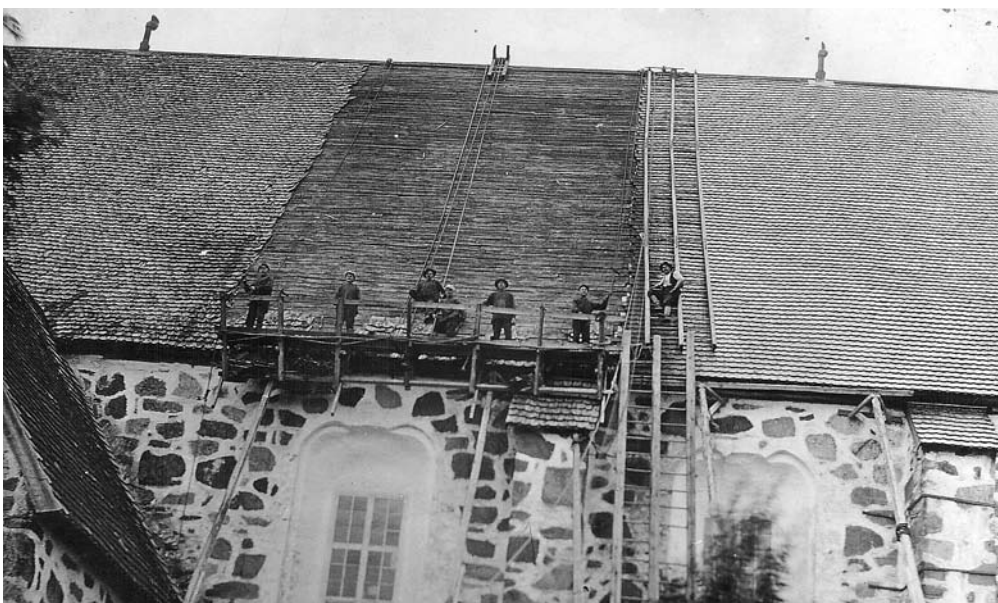
Vuonna 1925 uusittu paanutus on vielä hyväkuntoinen.
